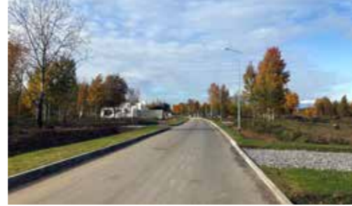
АСФАЛЬТИРОВАННАЯ ПРОЕЗЖАЯ ЧАСТЬ, ВЫВОЗ БЫТОВОГО МУСОРА
